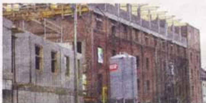
« Illico » sert de relais entre les clients et le monde de la construction
